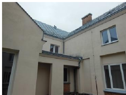
Zdj. nr 7 i 8. Elewacja niedocieplona tylna południowo-zachodnia oraz elewacja dziedzińca wewnętrznego niedocieplona.
