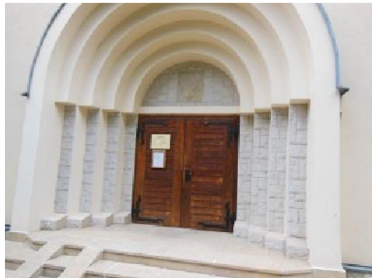
Zdj. nr 23 i 24. Stolarka drzwiowa drewniana, klepkowa, nieocieplona.
