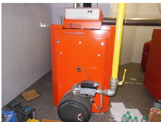
Zdj. nr 17 i 18. Ogrzewanie budynku Klasztoru realizowane przez dwa kotły gazowe jednofunkcyjne firmy Viessmann Paromat-Triplex o mocy 125 kW każdy (razem 250 kW) z 1998 roku. Kotły są z otwartą komorą spalania (palnikami atmosferycznymi). Ciepła woda użytkowa podgrzewana w podgrzewaczu zasobnikowym firmy Viessmann typu Rudo Cell.
