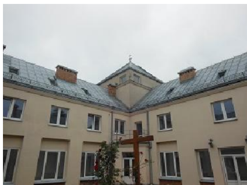
Zdj. nr 9 i 10. Elewacje dziedzińca wewnętrznego niedocięplone. Stolarzka okienna na profilach PCV z przeszkleniem zespolonym, dwuszybowym z końca lat 90-tych XX wieku.
