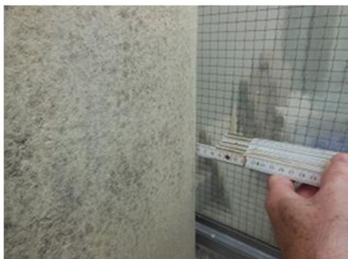
Zdj. nr 5 i 6. Pomiar docieplenia elewacji, styropian grubości 15 cm. Zdjęcie nr 6 z elewacją niedocieploną tylną południowo-zachodnią.
