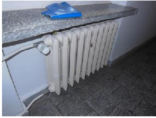
Zdj. nr 19 i 20. Wewnętrzna instalacja c.o. w budynku wodna, zamknięta, pompowa z grzejnikami członowymi i płytowymi, w części bez zaworów i głowic termostatycznych. Instalacja wykonana z rur stalowych.
