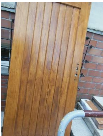
Zdj. nr 25 i 26. Stolarka drzwiowa drewniana, klepkowa, nieocieplona. Część pomieszczeń sanitarnych wyposażona w podgrzewacze elektryczne akumulacyjne c.w.u..
