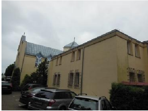
Zdj. nr 1 i 2. Elewacja frontowa północno-wschodnia oraz elewacja boczna północno-zachodnia. Obie elewacje docieplone styropianem grubości 15 cm.
