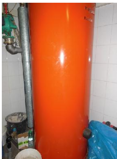
Zdj. nr 17 i 18. Ogrzewanie budynku Klasztoru realizowane przez dwa kotły gazowe jednofunkcyjne firmy Viessmann Paromat-Triplex o mocy 125 kW każdy (razem 250 kW) z 1998 roku. Kotły są z otwartą komorą spalania (palnikami atmosferycznymi). Ciepła woda użytkowa podgrzewana w podgrzewaczu zasobnikowym firmy Viessmann typu Rudo Cell.
