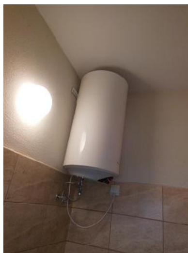
Zdj. nr 25 i 26. Stolarka drzwiowa drewniana, klepkowa, nieocieplona. Część pomieszczeń sanitarnych wyposażona w podgrzewacze elektryczne akumulacyjne c.w.u..
