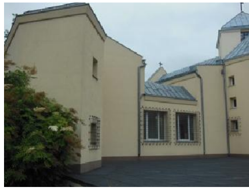
Zdj. nr 1 i 2. Elewacja frontowa północno-wschodnia oraz elewacja boczna północno-zachodnia. Obie elewacje docieplone styropianem grubości 15 cm.
