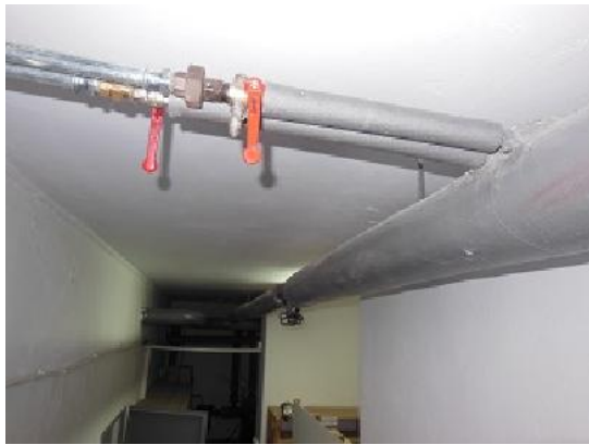
Zdj. nr 21 i 22. Instalacja wewnętrzna c.w.u. z rur stalowych skręcanych oraz rur PEX zaciskanych, PE zgrzewanych z cyrkulacją pracującą bez przerw.
