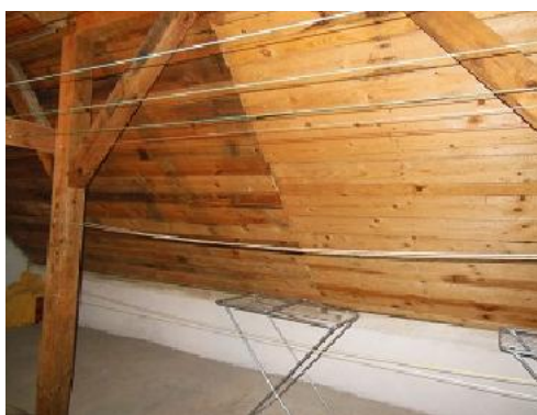
Zdj. nr 11 i 12. Dachy wysokie o konstrukcji drewnianej płatwiowo-kleszczowej, odeskowane i przykryte blachą.
