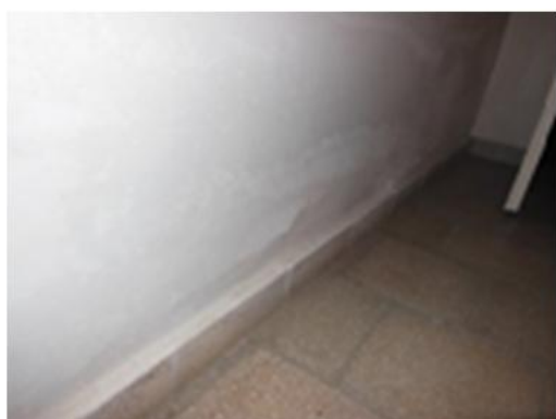
Zdj. nr 27 i 28. Ściany w gruncie piwnicy od strony N/W, S/W, części elewacji S/E oraz dziedzińca zawilgocone. Widoczne linie podciągania kapilarnego wody oraz silny atak mikroorganizmów. Tynk wewnętrzny odparzony i zdegradowany. Wymagają docieplenia w celu likwidacji mostków termicznych i zaizolowania izolacją przeciwwilgociową pionową i poziomą.
