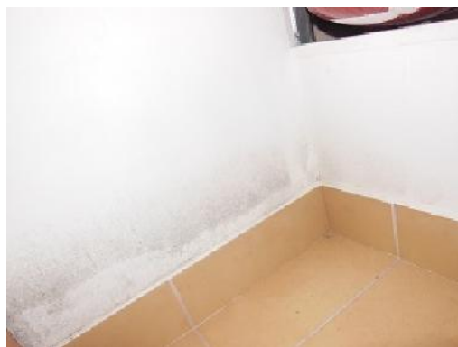
Zdj. nr 27 i 28. Ściany w gruncie piwnicy od strony N/W, S/W, części elewacji S/E oraz dziedzińca zawilgocone. Widoczne linie podciągania kapilarnego wody oraz silny atak mikroorganizmów. Tynk wewnętrzny odparzony i zdegradowany. Wymagają docieplenia w celu likwidacji mostków termicznych i zaizolowania izolacją przeciwwilgociową pionową i poziomą.
