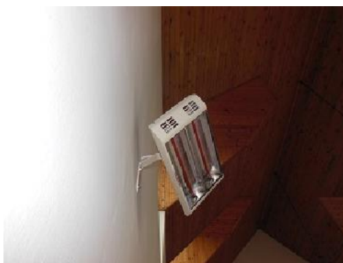
Zdj. nr 13 i 14. Pomieszczenie indywidualnej kaplicy sióstr dogrzewane promiennikami elektrycznymi na podczerwień
