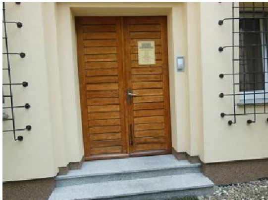
Zdj. nr 23 i 24. Stolarka drzwiowa drewniana, klepkowa, nieocieplona.
