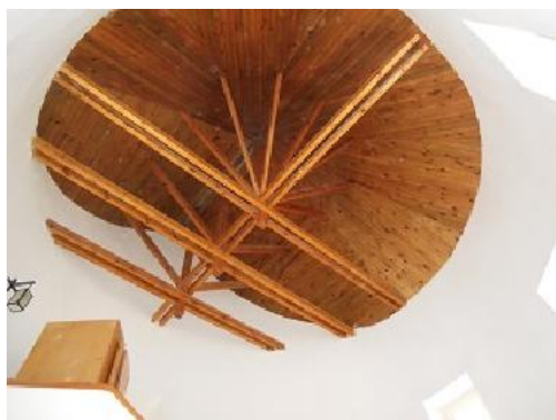
Zdj. nr 11 i 12. Dachy wysokie o konstrukcji drewnianej płatwiowo-kleszczowej, odeskowane i przykryte blachą.
