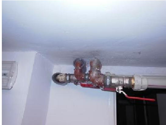
Zdj. nr 21 i 22. Instalacja wewnętrzna c.w.u. z rur stalowych skręcanych oraz rur PEX zaciskanych, PE zgrzewanych z cyrkulacją pracującą bez przerw.
