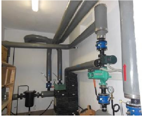
Zdj. nr 19 i 20. Wewnętrzna instalacja c.o. w budynku wodna, zamknięta, pompowa z grzejnikami członowymi i płytowymi, w części bez zaworów i głowic termostatycznych. Instalacja wykonana z rur stalowych.
