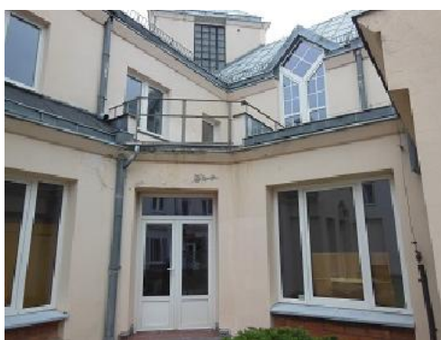
Zdj. nr 9 i 10. Elewacje dziedzińca wewnętrznego niedocięplone. Stolarzka okienna na profilach PCV z przeszkleniem zespolonym, dwuszybowym z końca lat 90-tych XX wieku.
